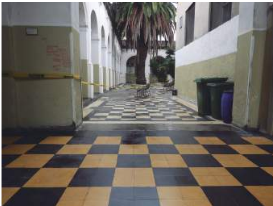
Cintas que pautan las restricciones de circulación. Hospital Vilardebó, ASSE. Fecha de captura: 8/6/2020. Registro fotográfico: Equipo MNP, 2020
